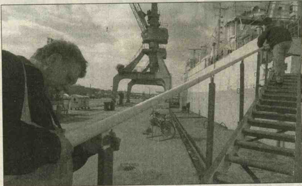
Vor allem die wackelige alte Treppe als einziger Ausgang des Kulturschiffs war der Grund für dessen Schließung. Sie ist jetzt durch eine neue ersetzt worden. Foto: Georg Scharnweber
